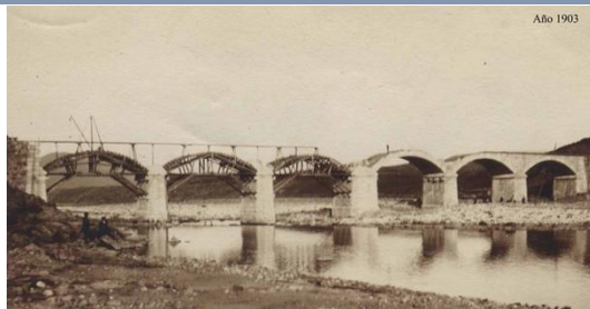
Año 1903 Construcción del Puente Nuevo
